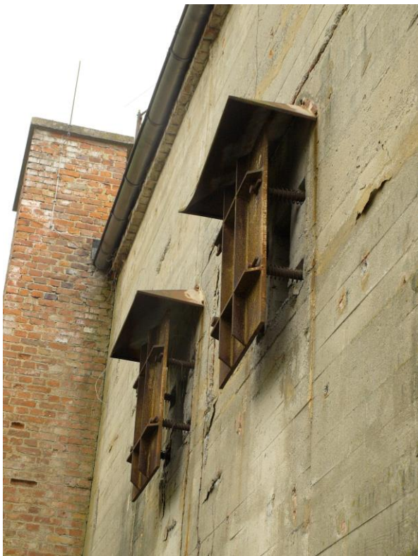
Der Bunker hatte eine aufwändige Lüftungsanlage mit Sandfiltern und Lüftungs-Ein- und Auslässen mit stabiler, federnd gelagerter Prallplatte gegen Druckwellen von Bomben.
