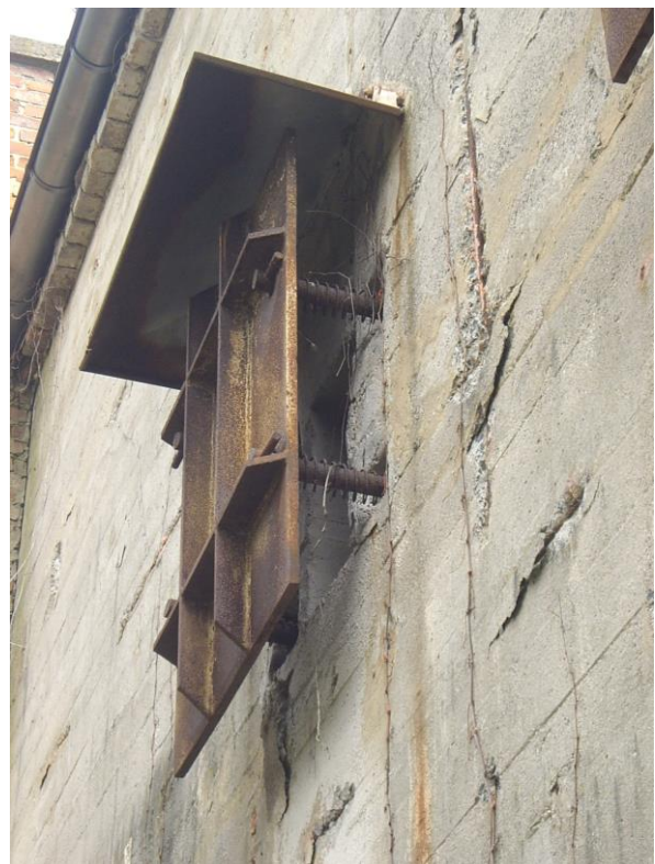
Der Bunker hatte eine aufwändige Lüftungsanlage mit Sandfiltern und Lüftungs-Ein- und Auslässen mit stabiler, federnd gelagerter Prallplatte gegen Druckwellen von Bomben.
