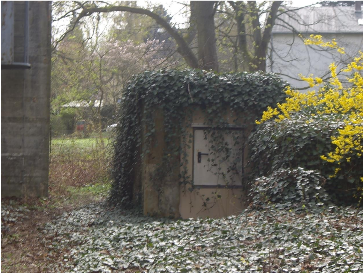
Neben dem großen Bunker befindet sich ein Brunnenhaus, über dessen technische Funktion nichts bekannt ist. Die Größe lässt vermuten, dass es sich um eine Zisterne für Regenwasser handelte.
