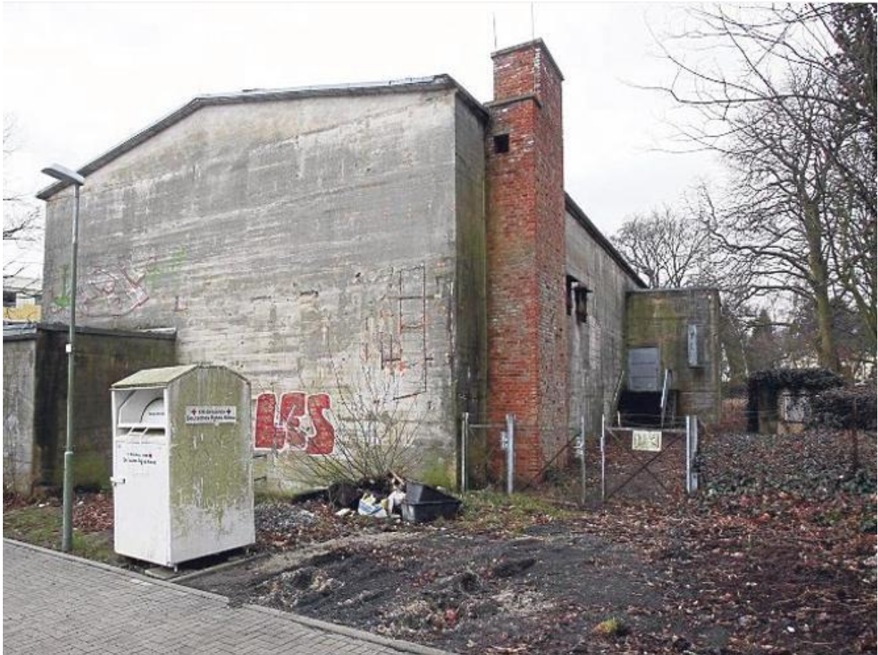
Hier ein Archivbild von Nordwesten, das noch einmal die Gesamtsituation zeigt. Die Schornsteinanlage wurde erst in der Phase „Kalter Krieg“ angebaut, als eine Heizungsanlage installiert wurde. Im ursprünglichen Zustand des Bunkers war die Heizungsanlage der Mensch.
