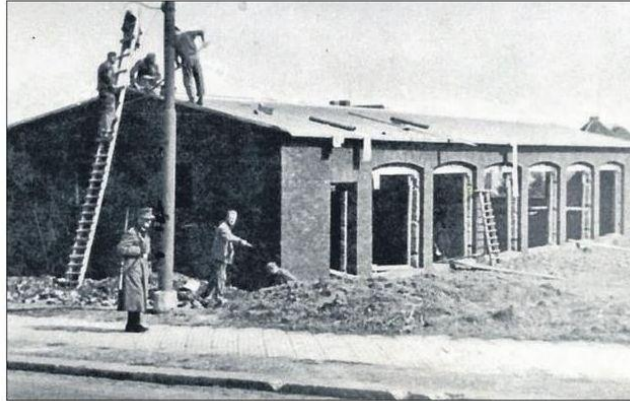
Inzwischen abgerissen: Diese Baracke gehörte zum Außenkommando. Die Häftlinge bauten sie unterhalb des Freibades Wilhelmshöhe an der Baunsbergstraße.
